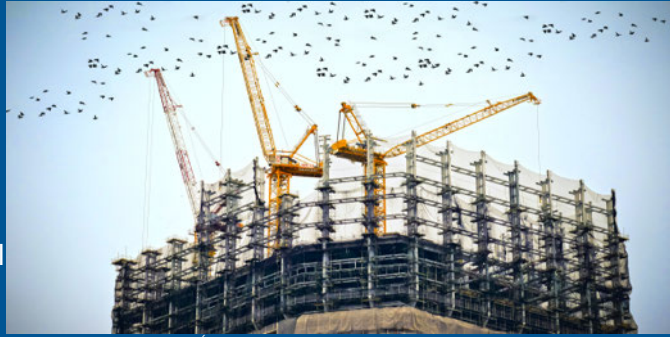
CONSTRUCCIÓN DE EDIFICIOS
